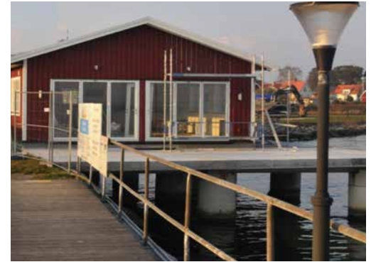
Klubbhuset är till stora delar placerad på pålar i vattnet.
